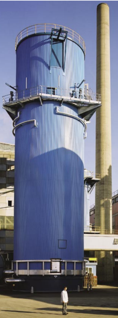
La nouvelle tour de diffusion à la sucrerie de Frauenfeld
