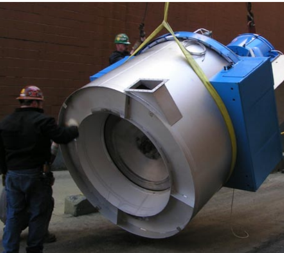
Einbringen einer Zentrifuge in das Gebäude
